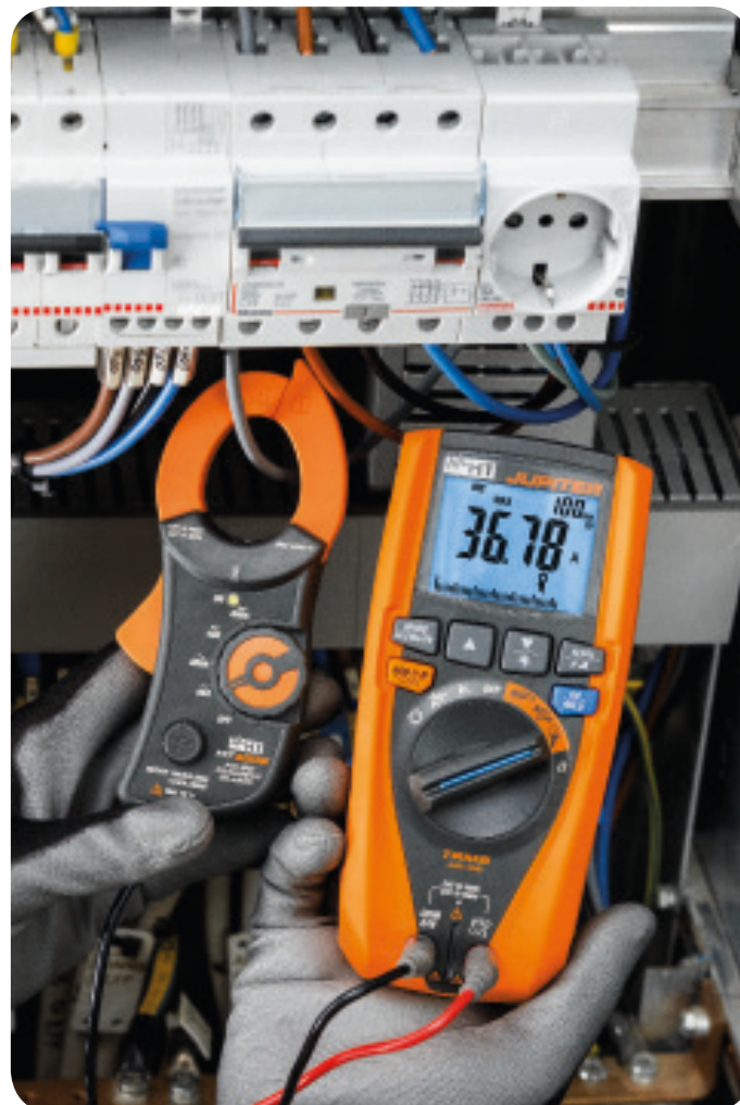
Messung des Einschaltstroms.
