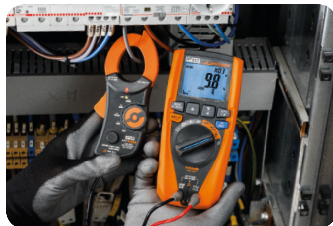
Strommessung der Harmonischen.
