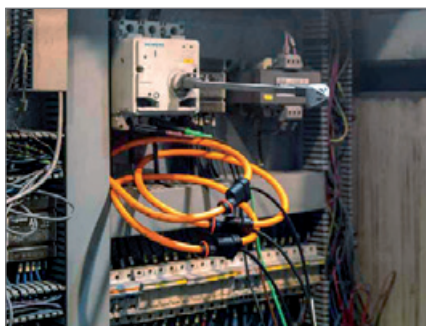
Messung Einsatz der flexiblen Stromwandler
