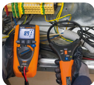
Messung des Stroms mit flexiblem Wandler.
