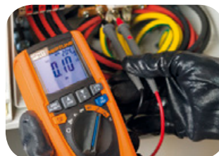
Durchgangsprüfung von Schutzleitern.
